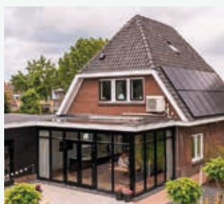
Aquarea T-CAP Wärmepumpe als Komplettlösung für Heizen, Kühlen und Brauchwarmwasserbereitung in einem luxuriösen Eigenheim. Voorthuizen, Niederlande. Aquarea
