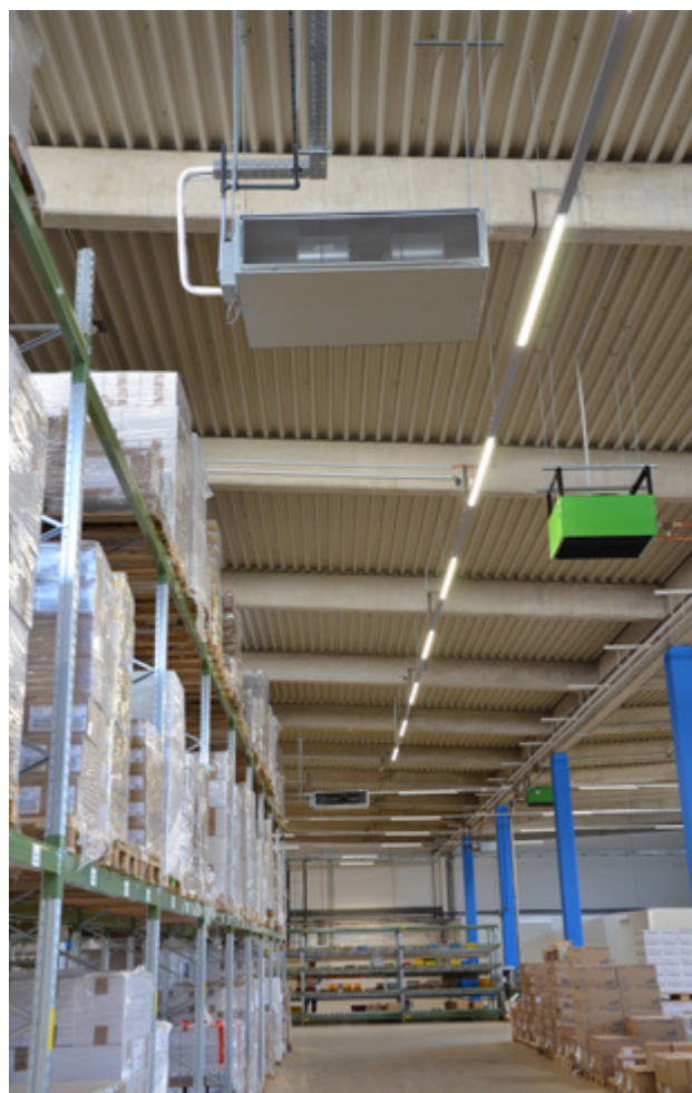
Offen montierte Kanalgeräte für direkte und effiziente Raumluftkonditionierung
