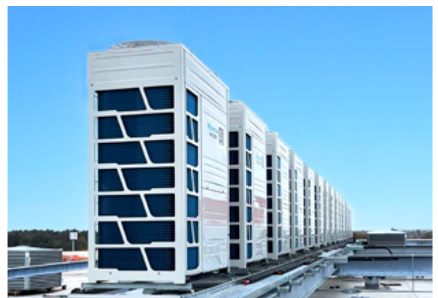
VRF-Außengeräte auf dem Dach des Möbelhauses
